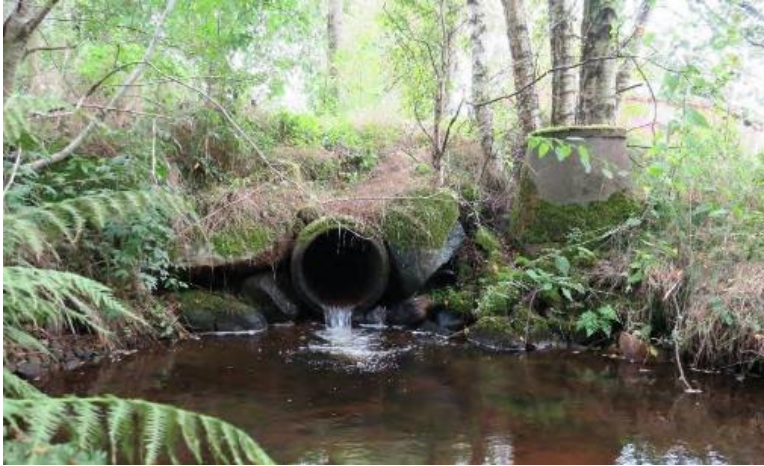
Exempel på fellagda vägtrummor
