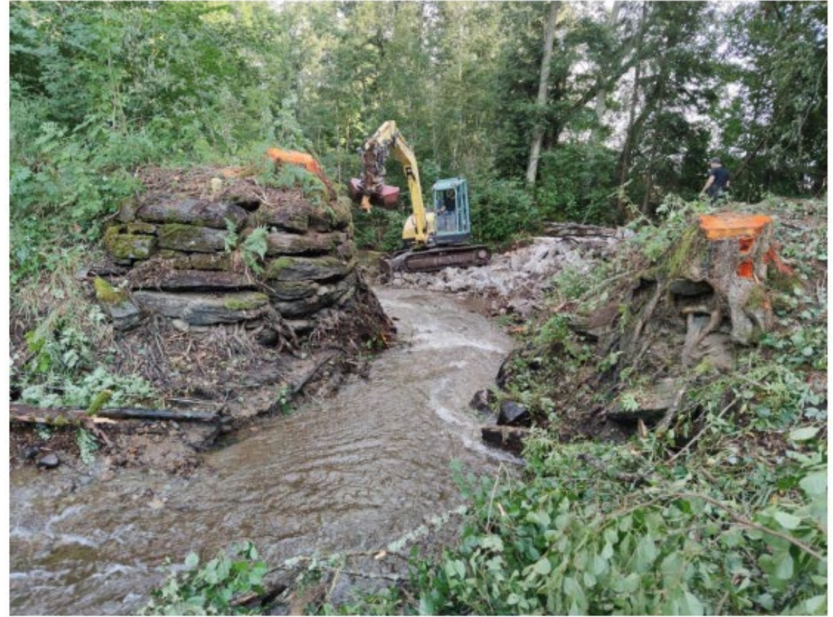
Figur 2. Under pågående åtgärd. Vy nedströms mot den utrivna kraftstationen. De fallna träden samt träden längst ut på dammvallarna är nedtagna. Det fallna betongutskovet i åfåran har avlägsnats.
