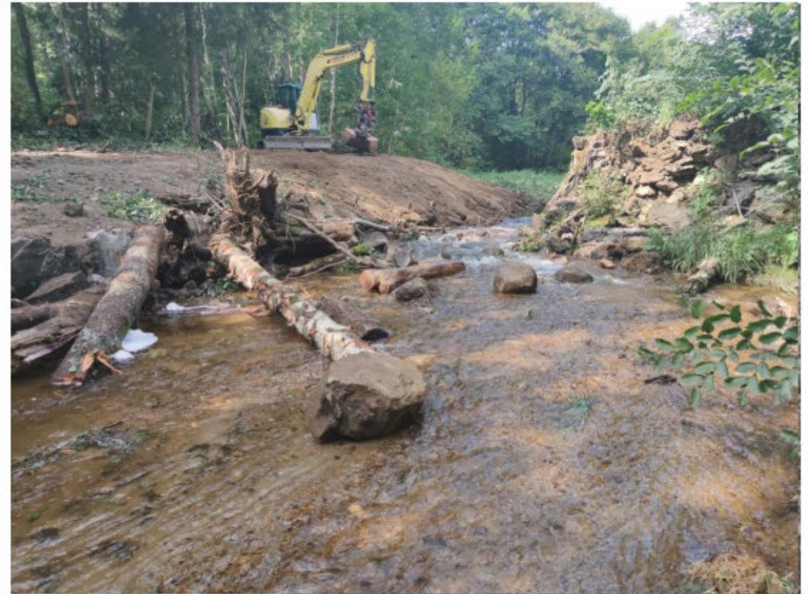
Figur 2. Efter åtgärd. Motsvarande vy som i bilden till vänster. Kraftstationen har avlägsnats och åfåran är återställd. Stenmaterialet i den bevuxna ön som bildades intill turbinsumpen har använts till att återställa åfåran. Nedfallna träd har avlägsnats.
