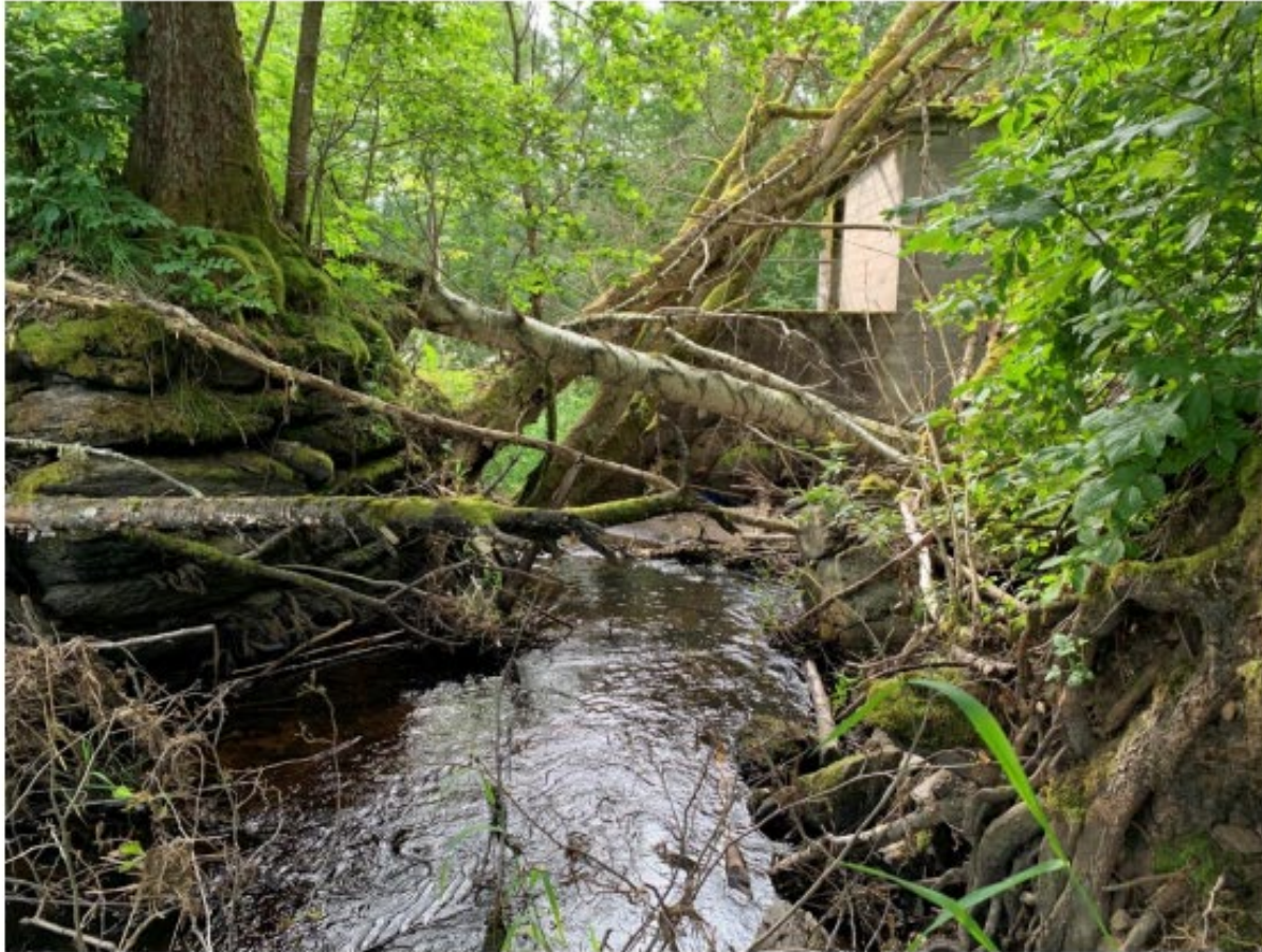
Figur 1. Före åtgärd. Vy nedströms mot kraftstationen genom öppningen i dammvallen.
