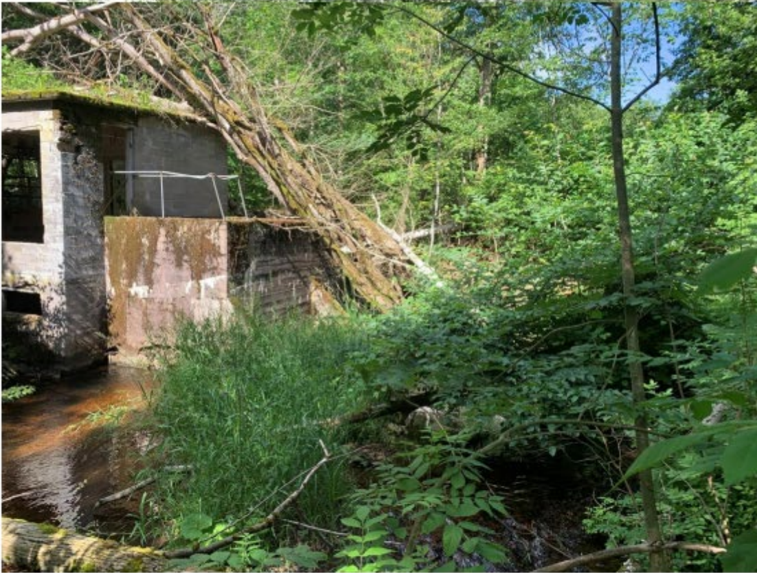
Figur 1. Före åtgärd. Vy snett uppströms mot kraftstationen från den vänstra stranden..
